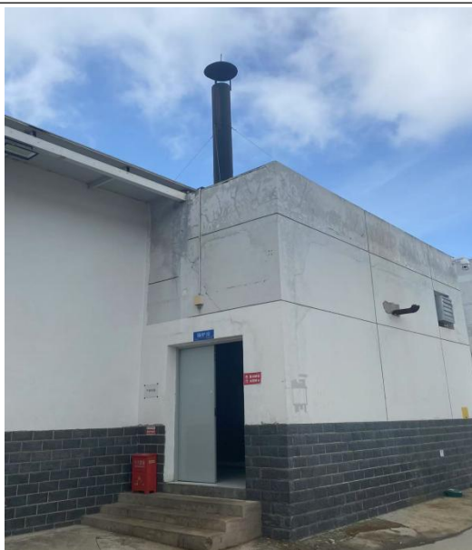
图 3-3 锅炉废气排气筒
